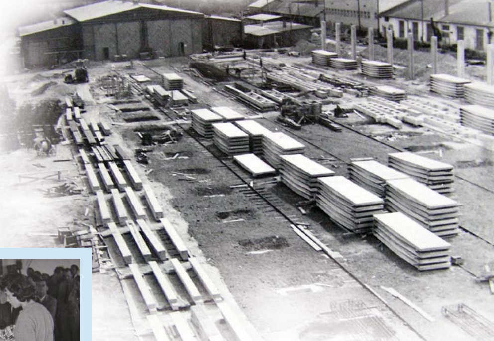
Fotografie z roku 1959: stavba slévárny, vpravo budova impregnace (tehdy nabíjecí stanice pro akumulátorové vozíky)
