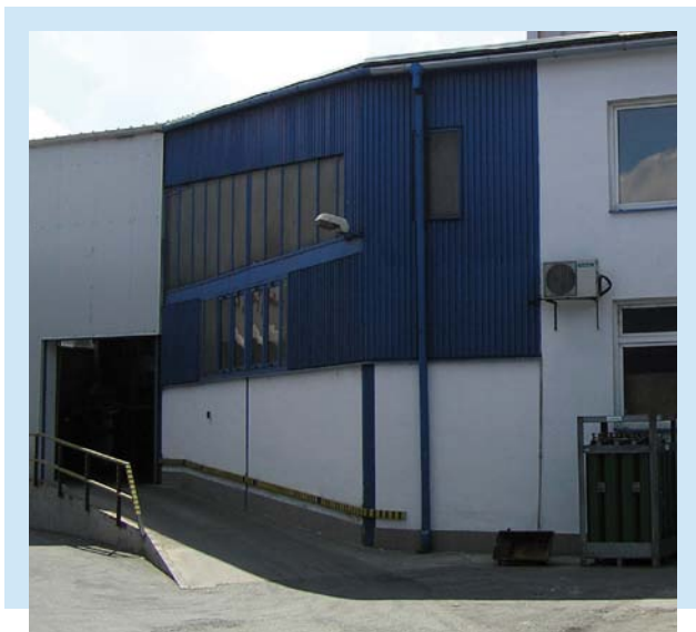
Tavírna po rekonstrukci
