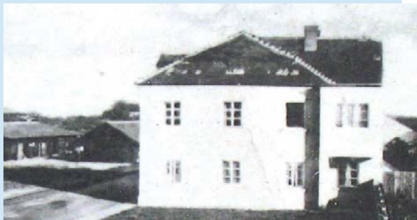
Současná administrativní budova kovárny (po roce 1933)
