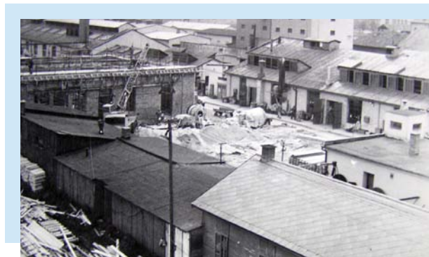
Stavba hlavní rozvodny. Budovy vpředu jsou na místě dnešní kovářny 1, budovy vpravo na místě dnešní kovářny 2
