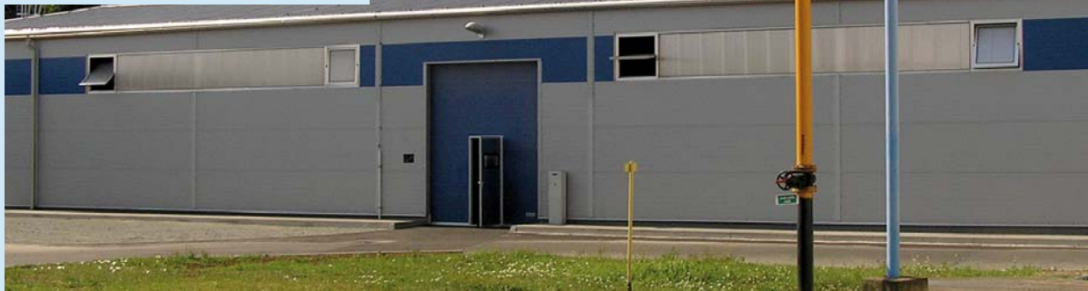
Nová skladová hala obrobny
