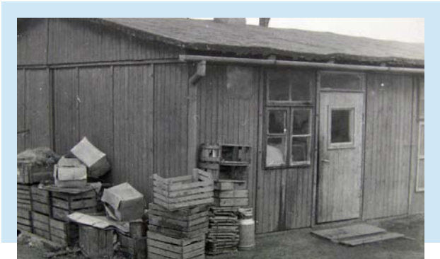
Kantýna z roku 1950. Opět se jedná o dřevěnou budovu
